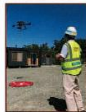
↑ドローン測量の様子
